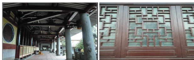
建筑檐廊装饰
