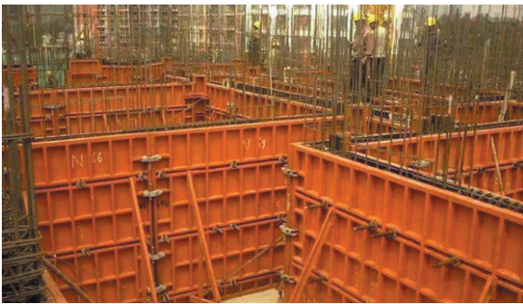
图3 再生骨料清水混凝土模板的施工效果
