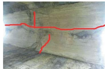
图7 2#腹拱横向、纵向裂缝
