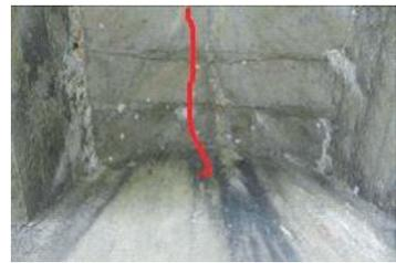
图6 3#拱波纵向裂缝、渗水泛碱
