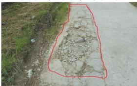
图4 铺装层压碎、坑洞
