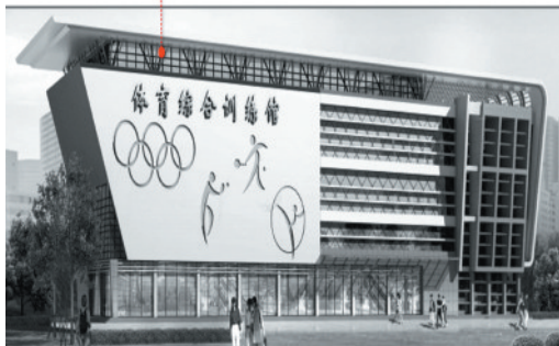
图4 玻璃幕墙取消后
